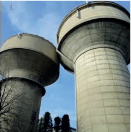
Réservoirs des Hubies Hauts (Le Chesnay-Rocquencourt)
