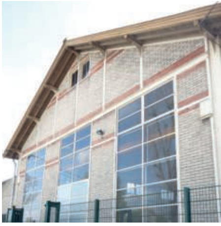
Station de pompage de Gobert (Versailles)
