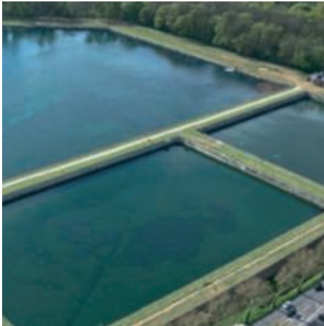
Réservoirs des Deux-Portes (Marly-le-Roi)
